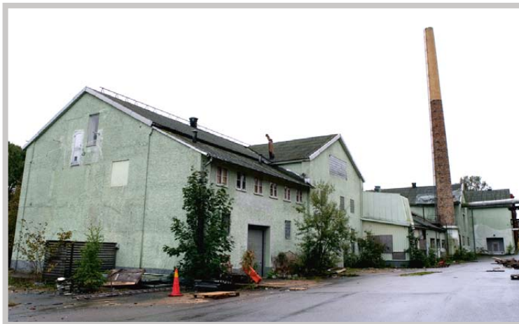
Detta är den gamla stärkelsefabriken som ska rivas och ge plats för ett flerfamiljshus med ett 45-tal lägenheter.
